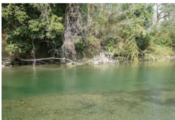
写真7 G地点の堰堤上左岸側（藤田撮影）
