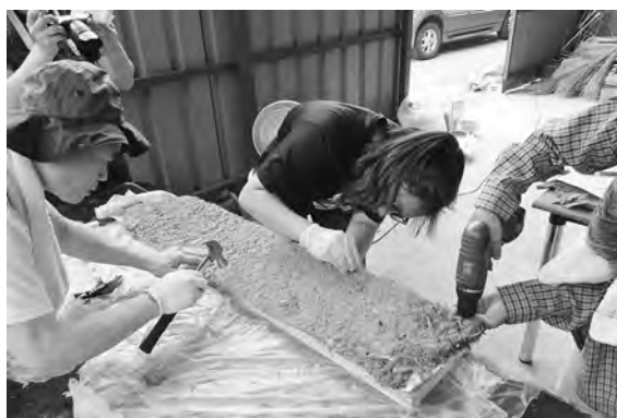
写真3. 仮釘で固定する
