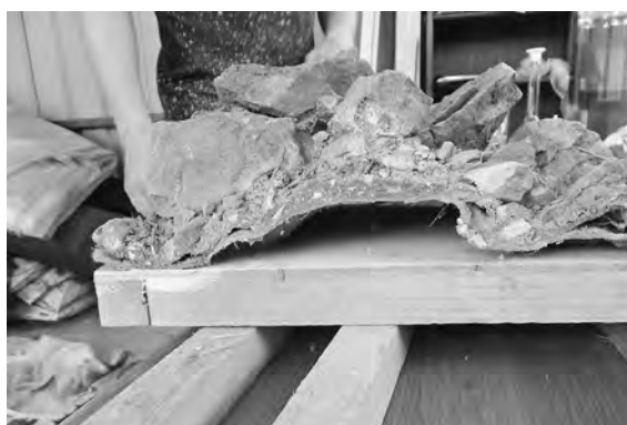
写真5. 端の部分に大きな空隙ができています。
